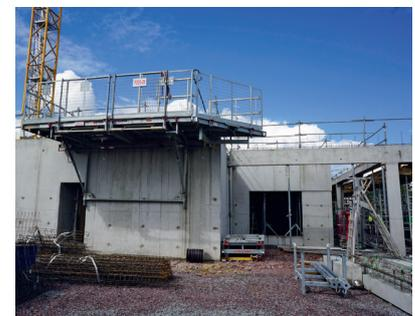
*Le gros œuvre est en cours, avec l'élévation de la structure en béton banché (un béton coulé entre deux moules).*
